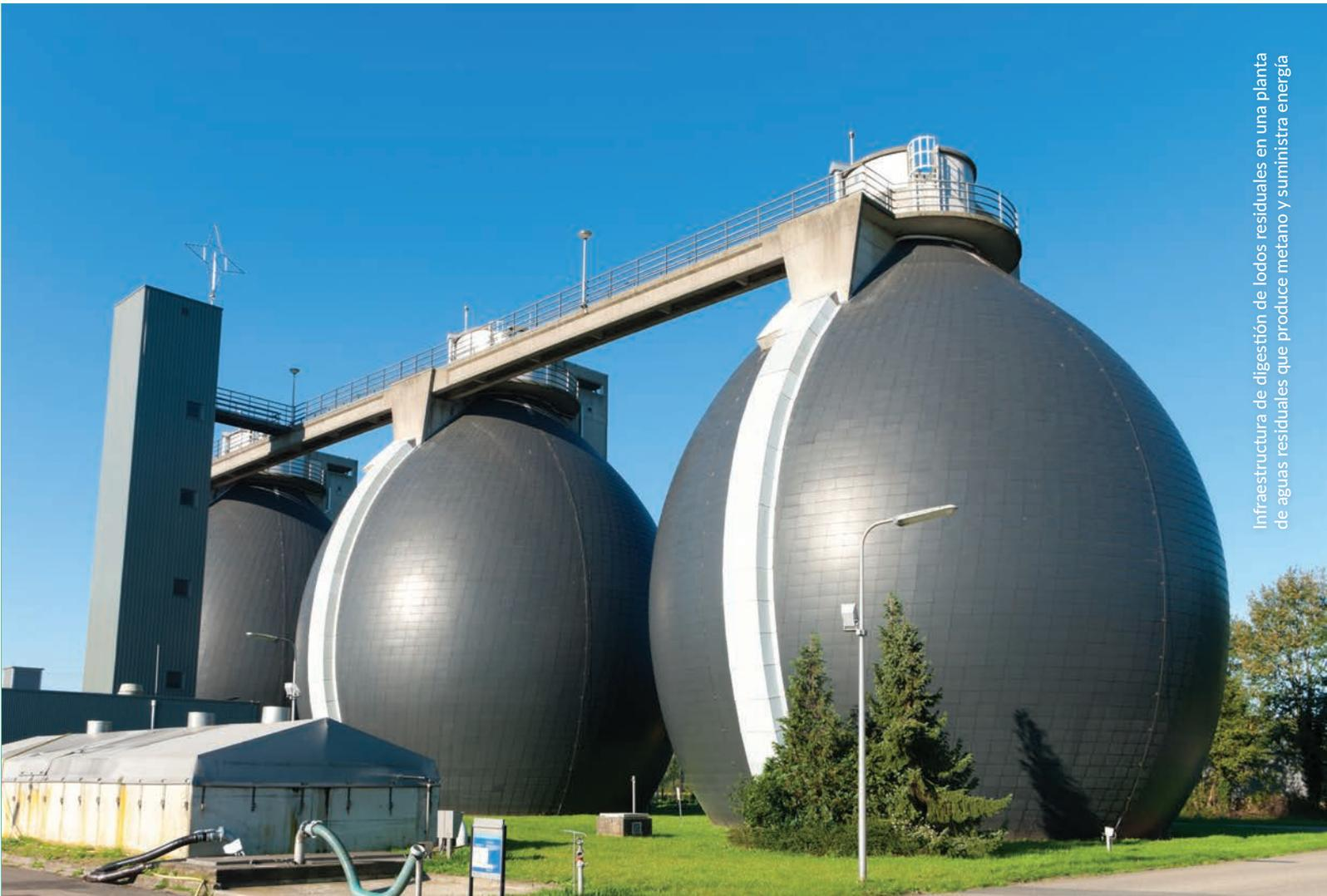
Infraestructura de digestión de lodos residuales en una planta de aguas residuales que produce metano y suministra energía
