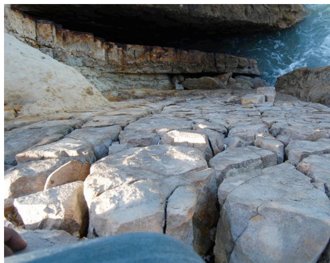
Foto 23. Vista desde arriba en el punto de la grieta en la costa rocosa. Estacion 5.
