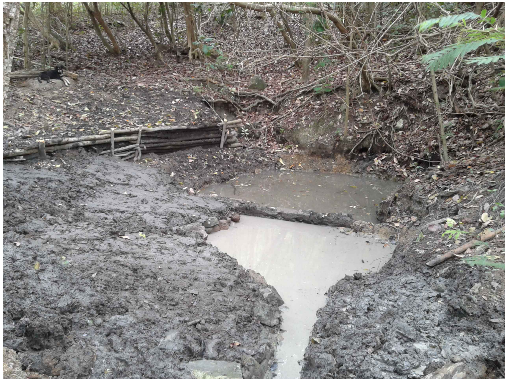
Ilustración 30: Estado final del sitio del de Sr Crispin, visto del lado del manantial
