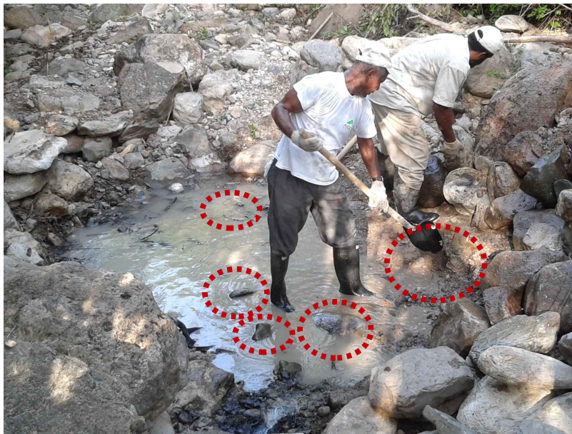
Ilustración 26: Ejemplo de profundización del lecho razonable y conservación de piedras profundas (en rojo)
