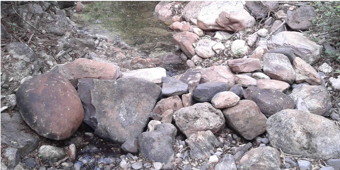
Ilustración 16: Ejemplo de consolidación de la parte alta del escudo
