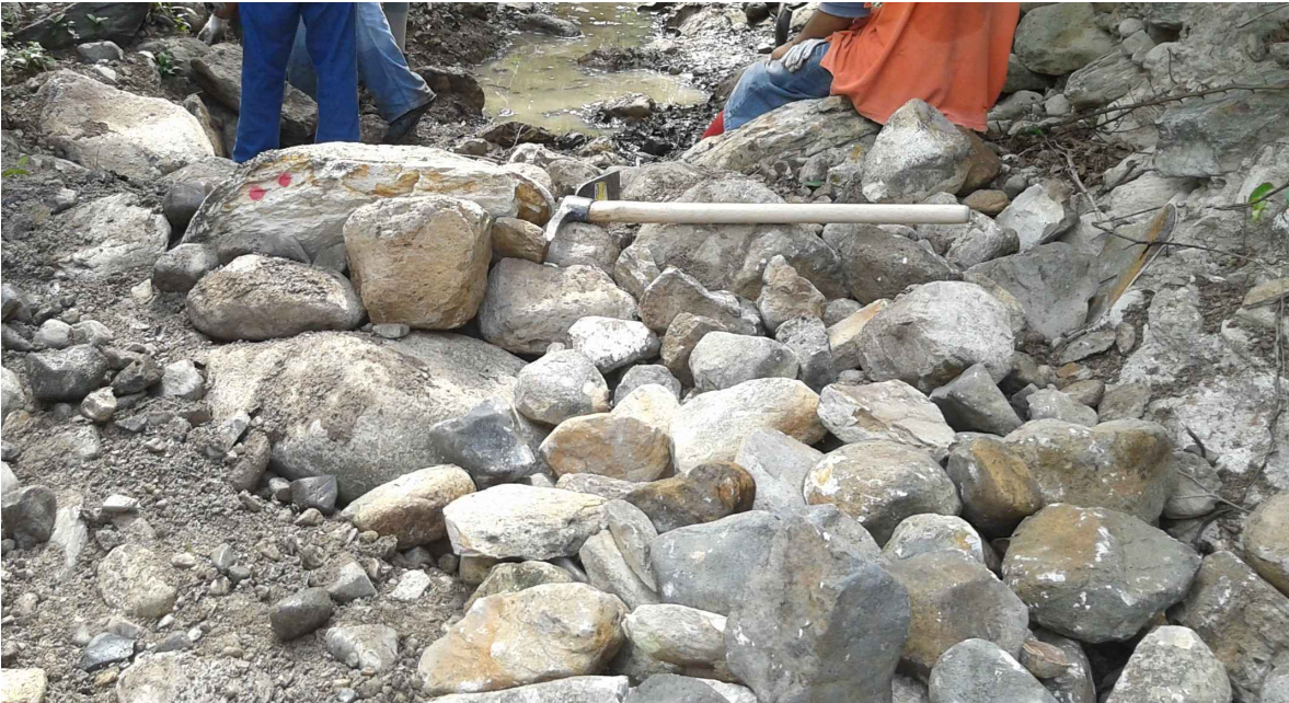
Ilustración 20: Ejemplo de protección hidráulica del rebose
