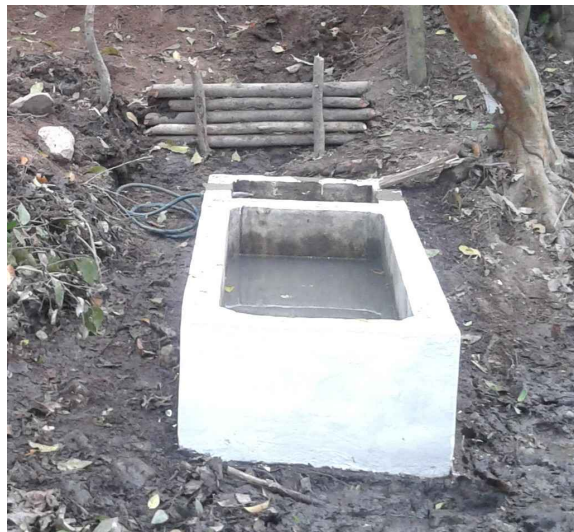
Ilustración 31: Estado final del abrevadero del Sr Crispin
