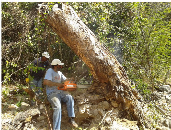
Ilustración 10: Ejemplo de corte de árbol y conservación de las raíces
